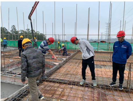
鹤山市住房城乡建设局检查“鹤山联塑实业发展有限公司扩建项目”和“鹤山国际陆港一期工程”
