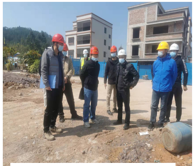
恩平市住房和城乡建设局检查“恩平市汇银房地产开发有限公司汇银江南富湾项目高层住宅六期建设”
