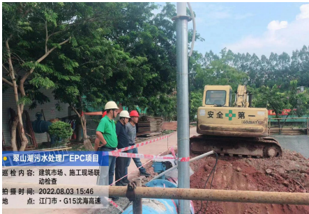
开平市住房和城乡建设局检查“翠山湖污水处理厂改造及中水回用项目EPC”
