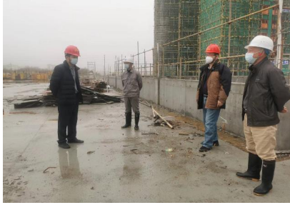
恩平市住房和城乡建设局 检查“锦峰雅苑”
