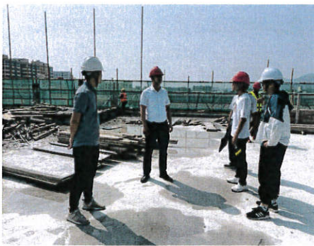
江门市住房和城乡建设局检查 “江门市应急救灾物资仓库项目”
