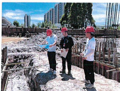
恩平市住房和城乡建设局检查 “恩平工业园人才培训基地项目”
