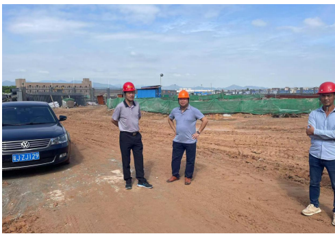
江门市住房和城乡建设局联合新会区住房和城乡建设局检查“杰成新能源材料项目”
