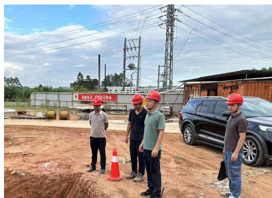
恩平市住房和城乡建设局检查“广东亿盛科技投资有限公司厂房及附属设施建设项目”
