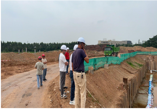
开平市住房和城乡建设局检查“开平市城区楼冈及月山、水口、苍城、大沙四个镇级污水处理设施 PPP 项目-开平市城区楼冈生活污水处理厂（一期）”
