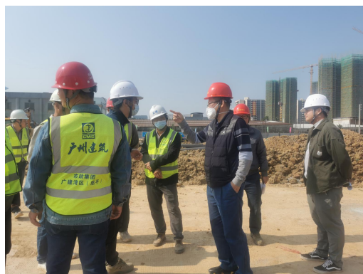
恩平市住房和城乡建设局检查 “恩平市达佳电子有限公司厂房 一”
