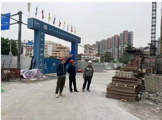
蓬江区住房和城乡建设局检查“ 荷塘卫生院升级改造工程”
