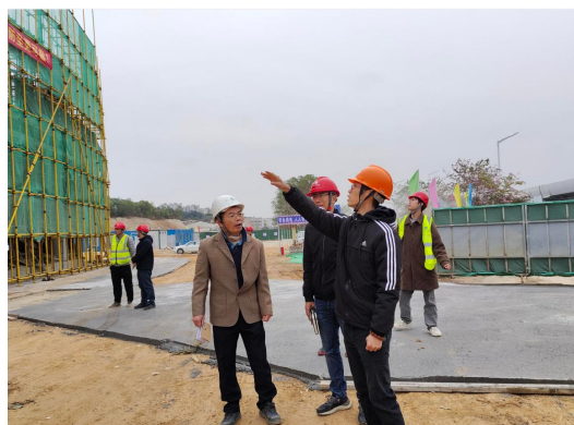
新会区住房和城乡建设局检查“江门市城区汽车客运站（一期）”
