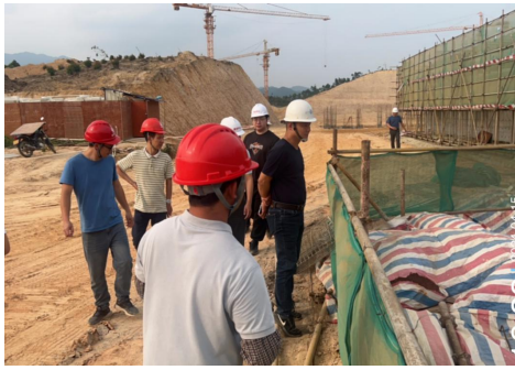
开平市住房和城乡建设局检查 “开平市水暖卫浴产业配套基地 (共性工厂)项目-污水处理厂”
