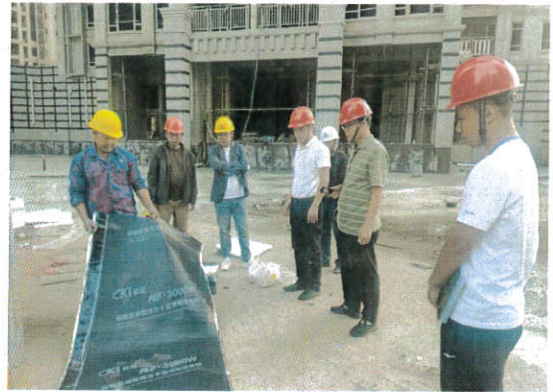
恩平市住房和城乡建设局检查“恩平市汇银房地产开发有限公司江南富湾项目高层住宅六期建设项目”
