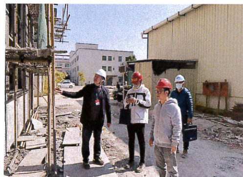
恩平市住房和城乡建设局检查“恩平市金格电子有限公司--厂房一、门卫”项目
