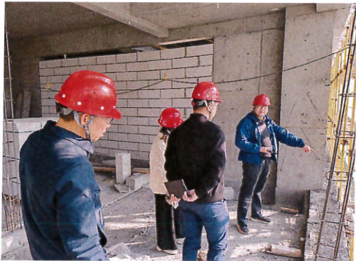
江海区住房和城乡建设局检查 “礼乐中学宿舍楼”项目
