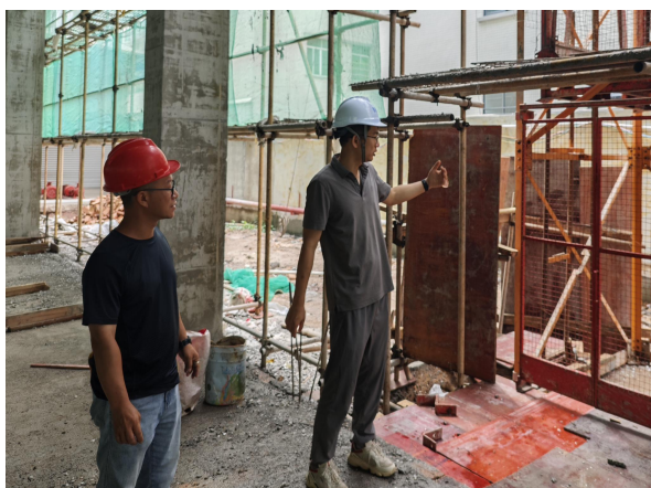
恩平市住房和城乡建设局检查“恩平市晋升音频有限公司厂房及配套设施建设项目（厂房二）”项目
